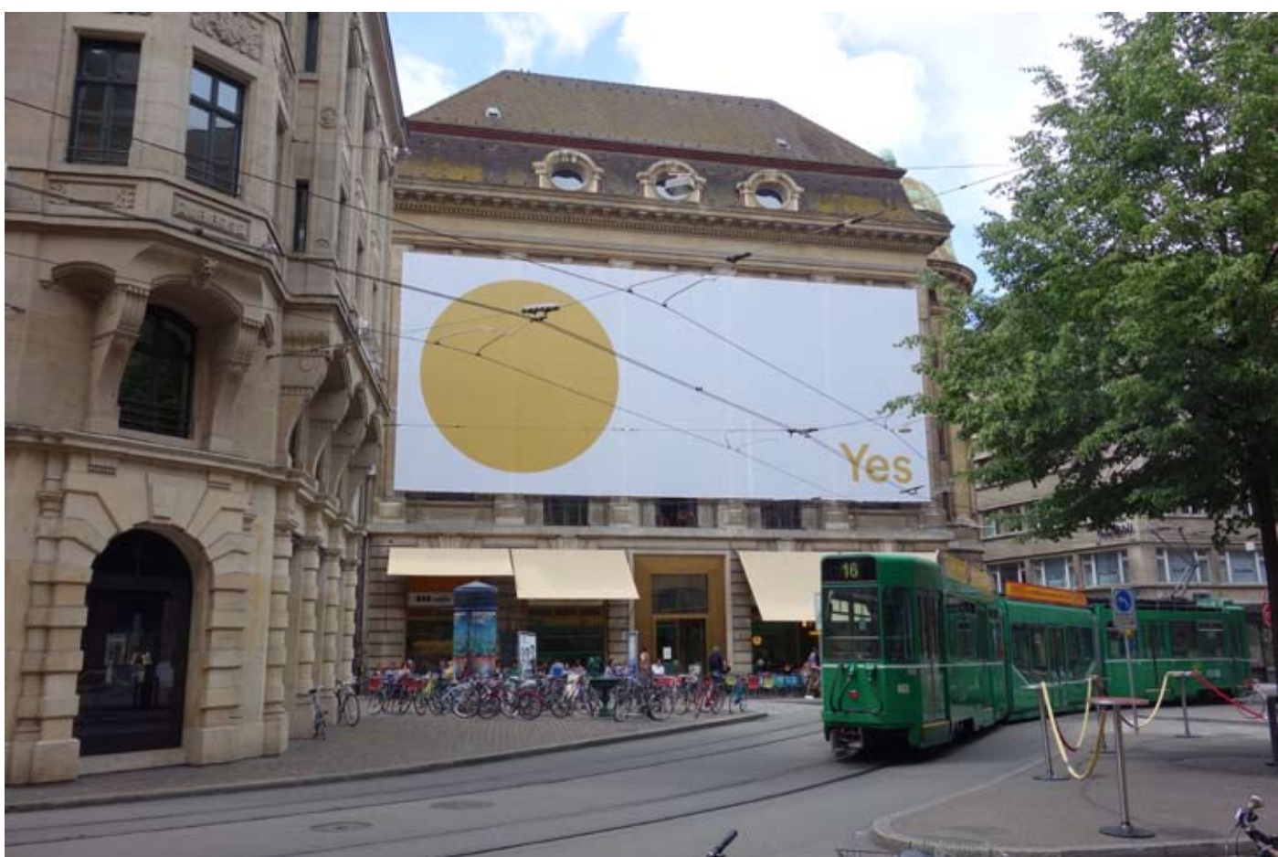
Basel, bâche sur la façade du «Unternehmen Mitte»
